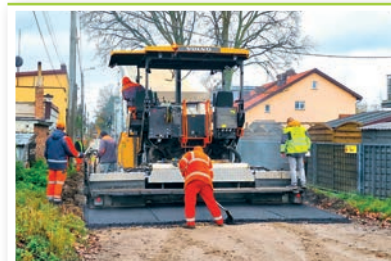
Układanie asfaltu w ulicy Żabiej
